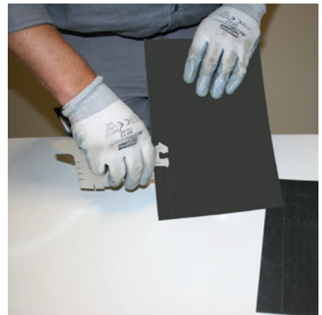
Traceren van de overlappende delen
