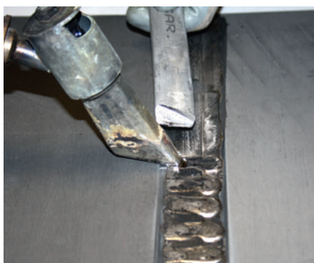
Aanbrengen van een toevoegmetaal
