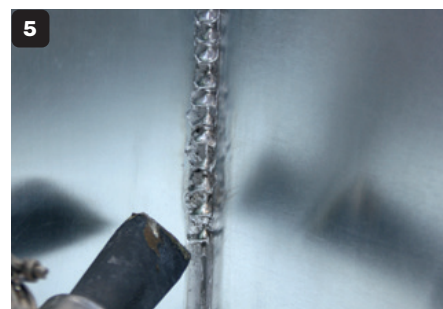
Realisatie van een geribde versterkte soldering op de gladde soldering.
