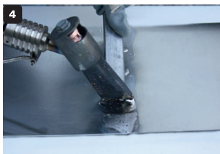
Realisatie van een gladde soldering. Aanbrengen van extra toevoegmetaal.
